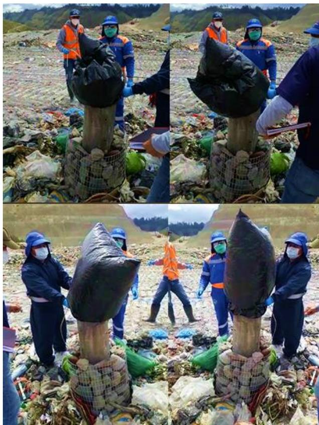
**Figura 29.** Técnica de sellado con funda plástica a pozo de venteo
