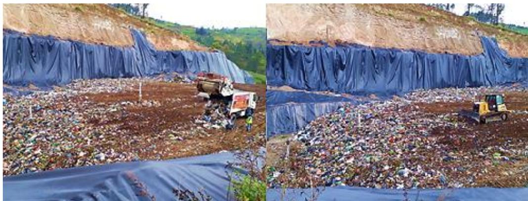
**Figura 26.** Colocación y compactación de los RSU
