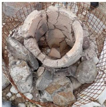
**Figura 15.** Vista superior de un pozo obstruido en el relleno sanitario de Ambato
