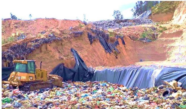
**Figura 9.** Técnica de relleno en celda, relleno sanitario de Ambato
