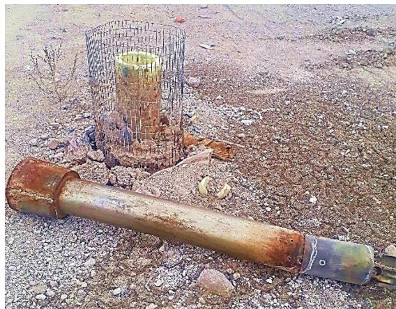
**Figura 3.** Pozo y quemador en relleno sanitario de Ambato
