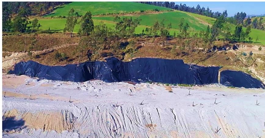
**Figura 1.** Disposición de geomembrana en relleno sanitario de Ambato
