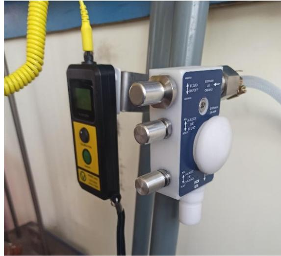
**Figura 10.** Conexión a toma de oxígeno
