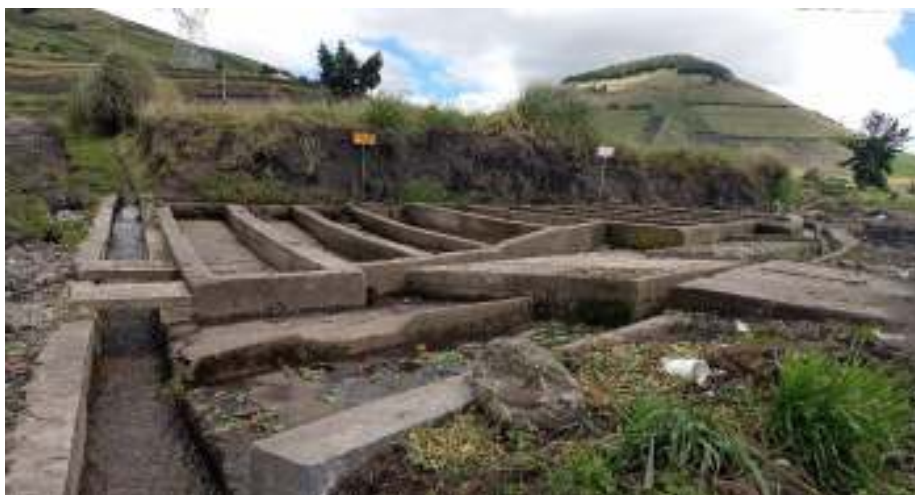
Ilustración 15 Levantamiento de infraestructura existente
