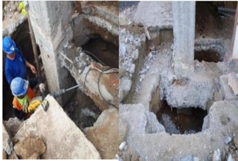
Figura: Demolición de tramos de vigas de amarre, para dar paso a la continuidad del acero longitudinal del muro
