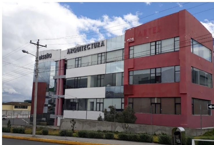
Figura 25: Estado Actual de la Estructural
