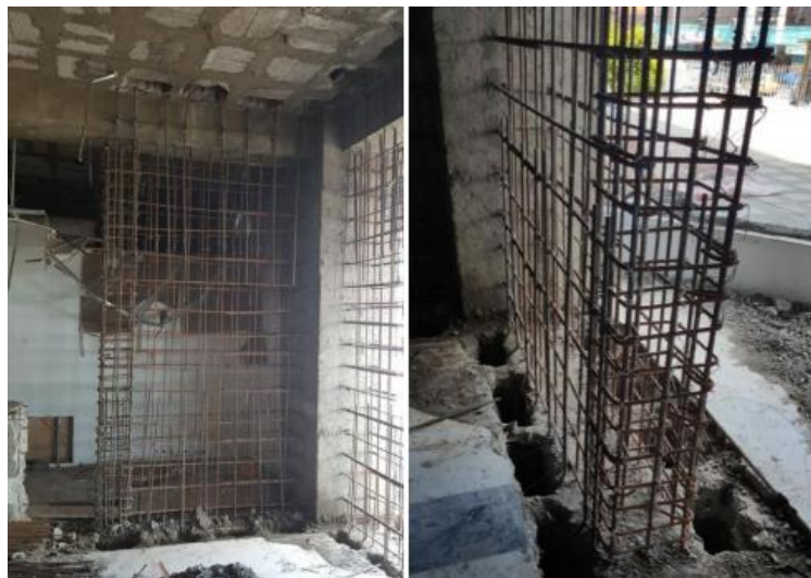
Figura: Armadura de continuidad del refuerzo vertical.
