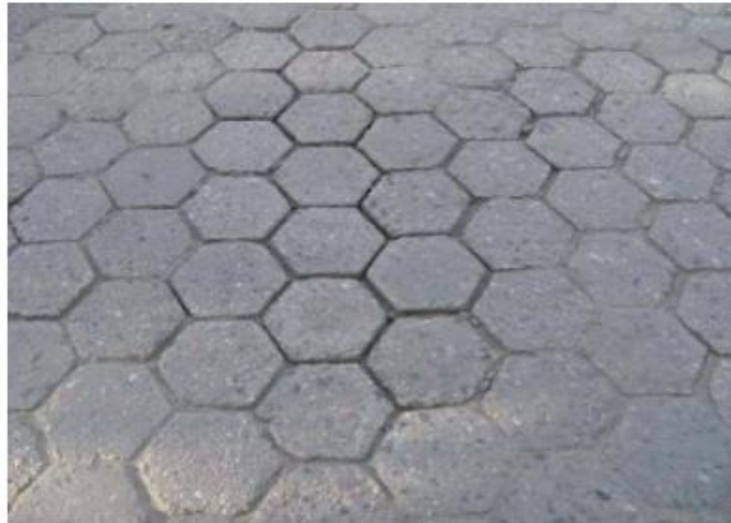
Figura N° 36: Juntas abiertas
