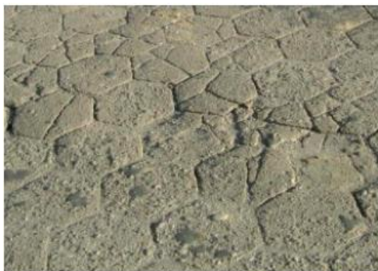
Figura N° 35: Fracturamientos
