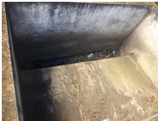
Figura 21: Lecho de Secado de Lodos de la PTAR. Fuente: Autor.
