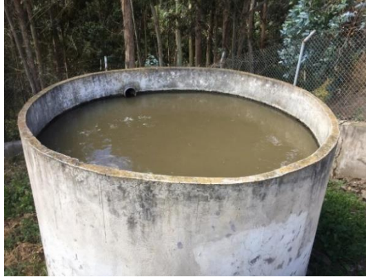
Figura 20: Filtro Biológico Ascendente de la PTAR. Fuente: Autor.
