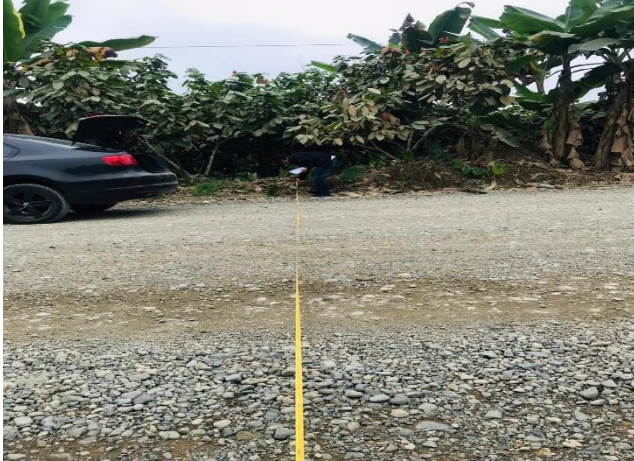
Medición del ancho de la vía, 8 metros sin contar con las cunetas
