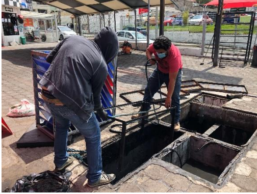
Colocación de Subestructura
