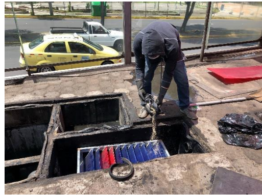
Colocación de Coagulante Natural
