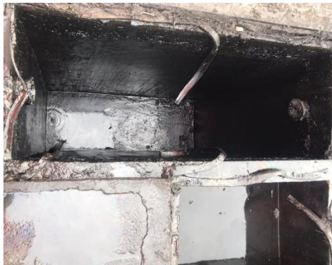
Limpieza del Sedimentador
