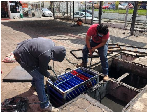
Colocación de Estructura Metálica con Planchas de Policarbonato
