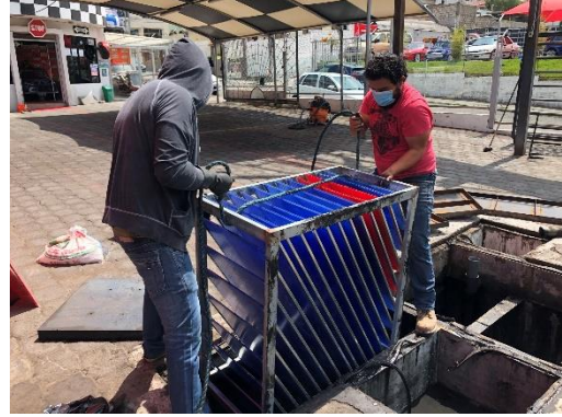
Colocación de Estructura Metálica con Planchas de Policarbonato
