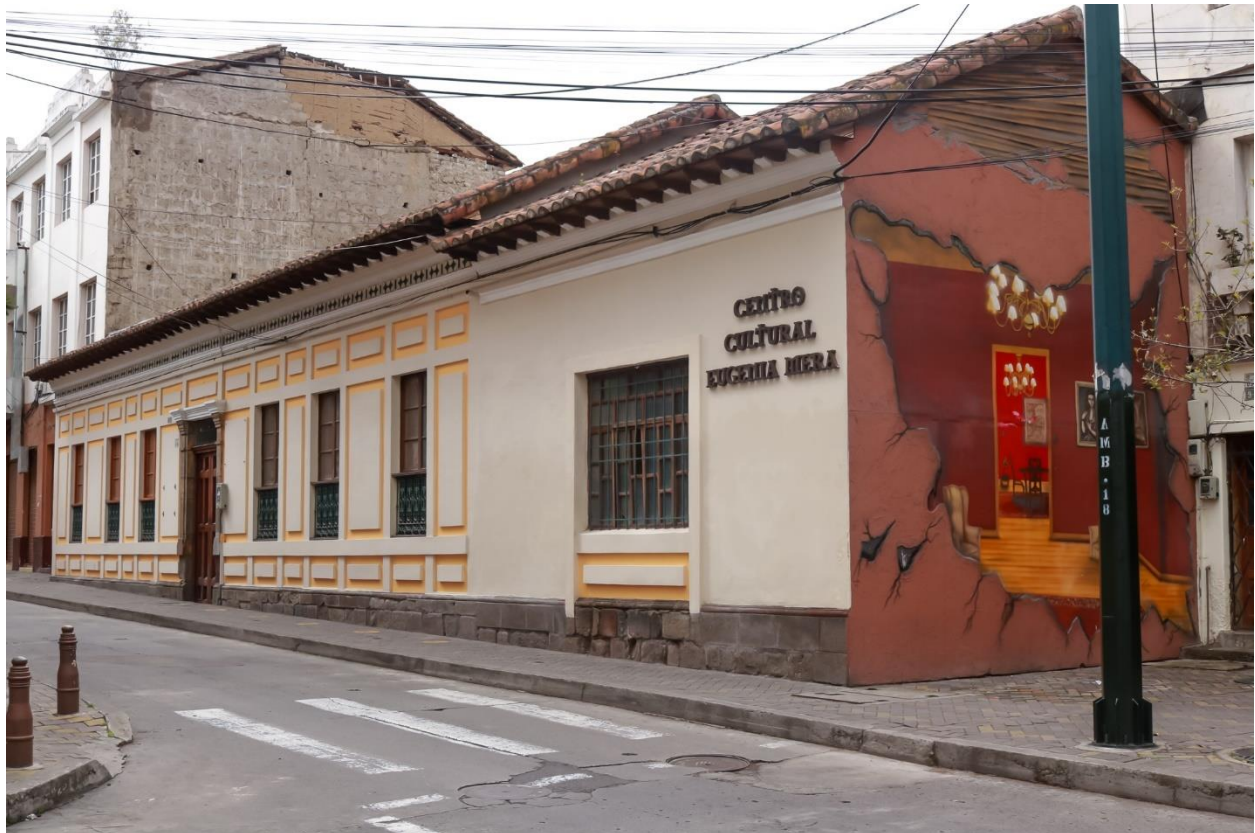
Ilustración 23 Fachada Centro Cultural Eugenia Mera (Toro 2020)
