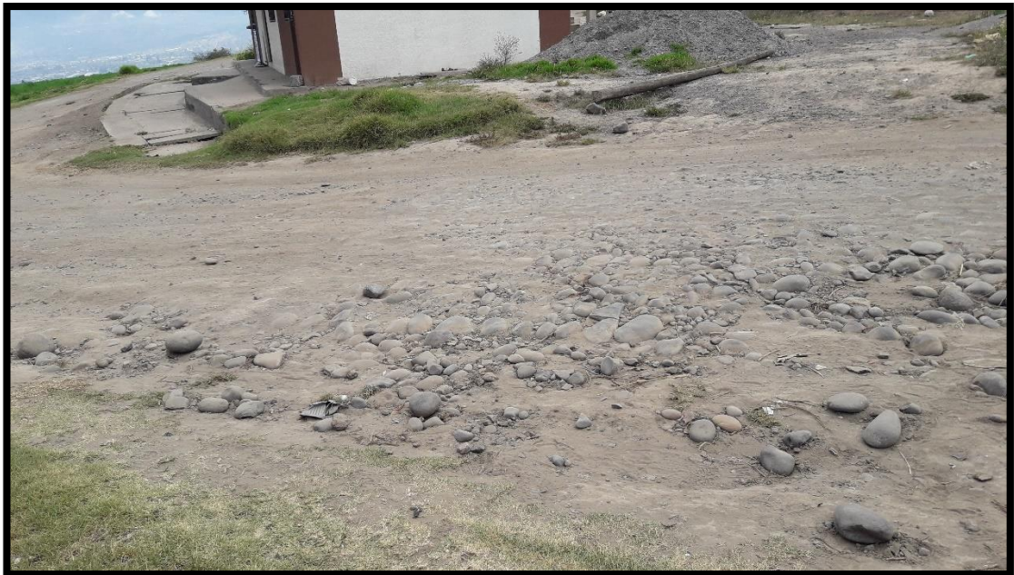
Estado actual de la vía
