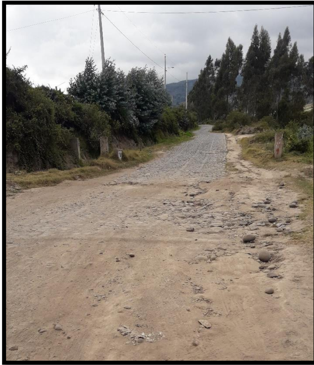
Estado actual de la vía
