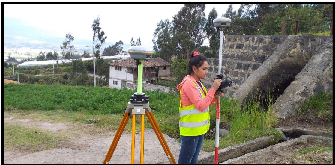
Realización del levantamiento topográfico, calibración del móvil del RTK
