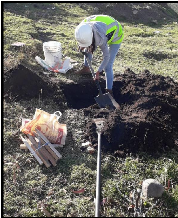
Realización de calicata
