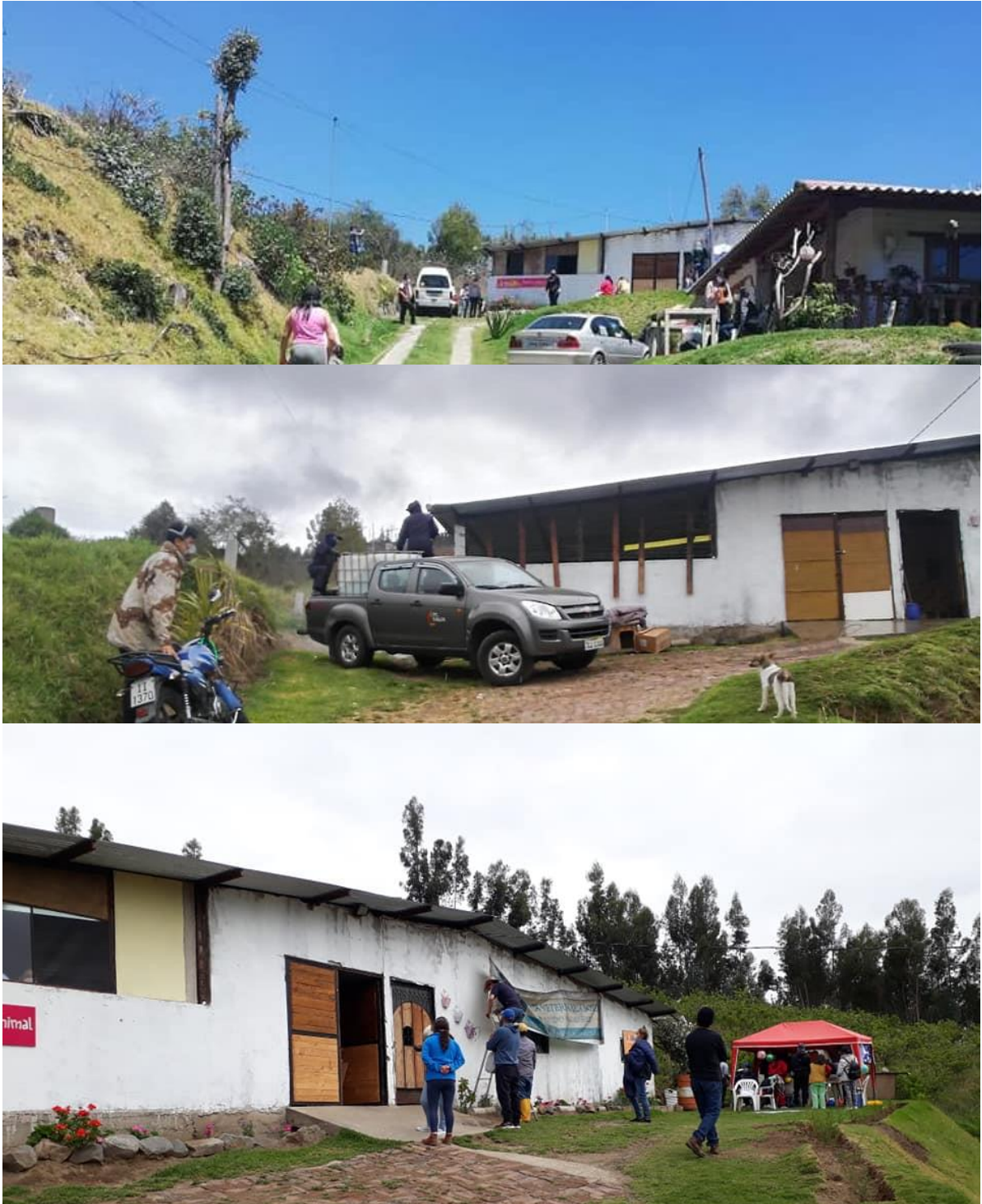
Gráfico 9 Fachada principal del "Refugio Kodah"
