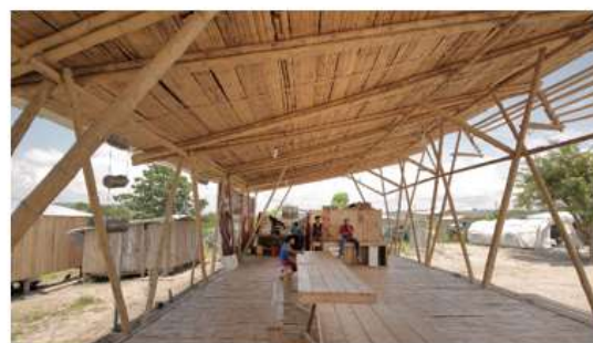
Ilustración 19. Interior casa Comunal Renacer Fuente: Plataforma Arquitectura, 2016
