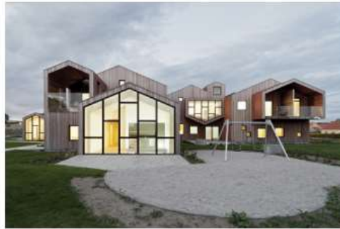
Ilustración 23. Fachada del Hogar de menores (Cebra) Fuente: Plataforma Arquitectura, 2014
