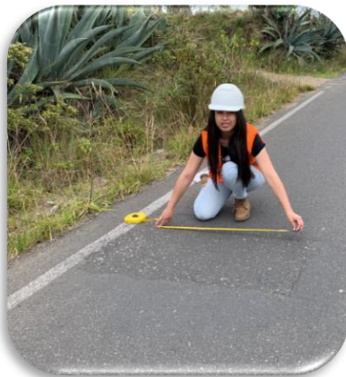
Fotografía 9. Medida de Fallas
