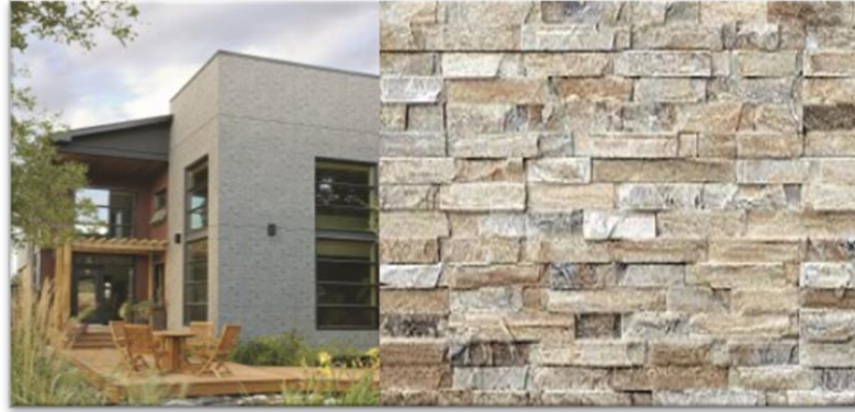
Figura 2.3. Pared recubierta de fachaletas
