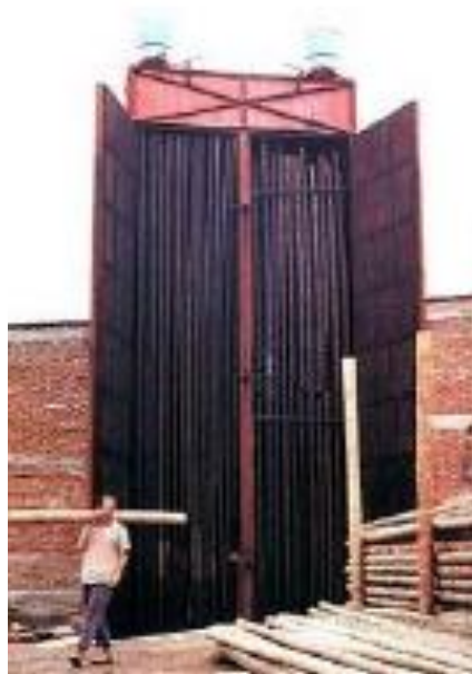
Imagen 33: Pared de bambú con tejido para el enlucido. Fuente: Calva, 2015.
