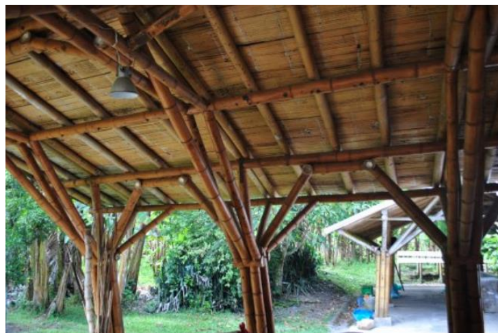
Imagen 3: Estructura hecha de caña guadua. Fuente: Tripadvisor. Co, 2019.
