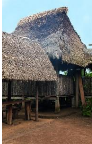
Imagen 6: Cabaña con estructura de bambú y techo de paja toquilla. Fuente: Guerrero, 2016.
