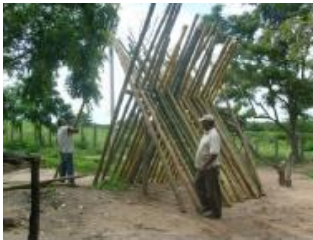
Imagen 34: Pared de bambú con tejido para el enlucido. Fuente: Calva, 2015.
