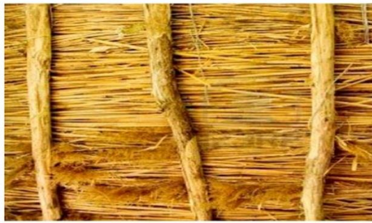
Cobertura de paja reforzada
