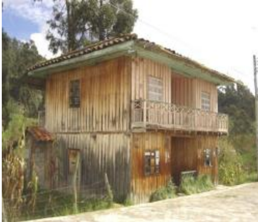
Imagen: 18: Vivienda vernácula en la Amazonía ecuatoriana. Fuente: Estudio de los sistemas constructivos tradicionales en madera, 2010
