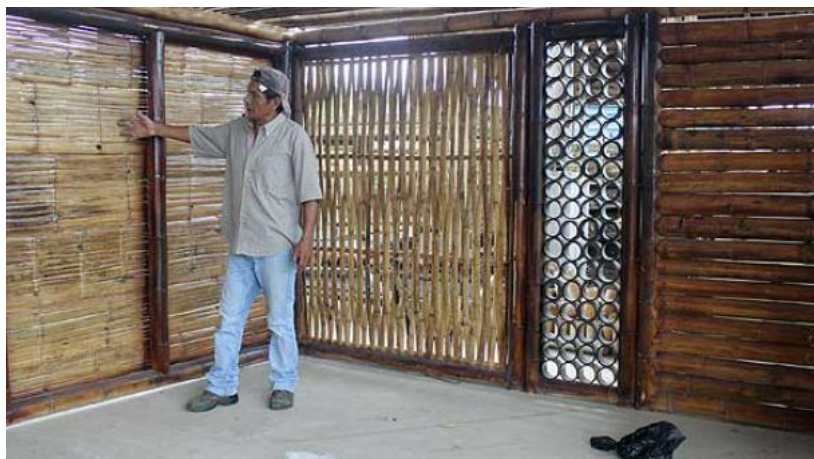
Imagen 7: Estructura y paredes hechas con madera de bambú. Fuente: Velasco, 2017.
