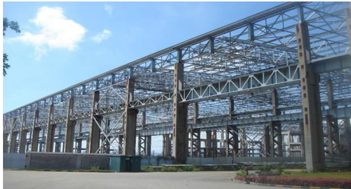
Figura 2-4 Estructura de acero.
