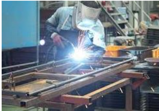
Figura 6-40 Soldadura del material Fuente: Autor
