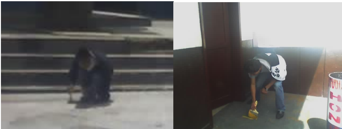
Fig. 40 pintando las rutas de evacuación
