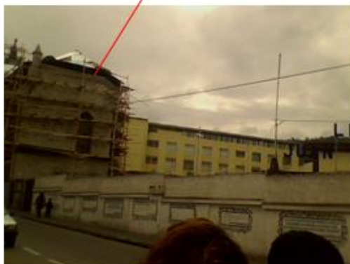
Fig.11: Iglesia de la Medalla Milagrosa en reparación
