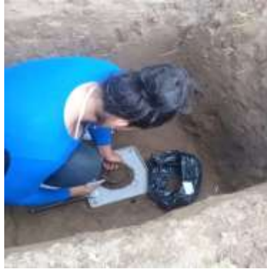
Figura 23. Excavación para determinar la densidad de campo
