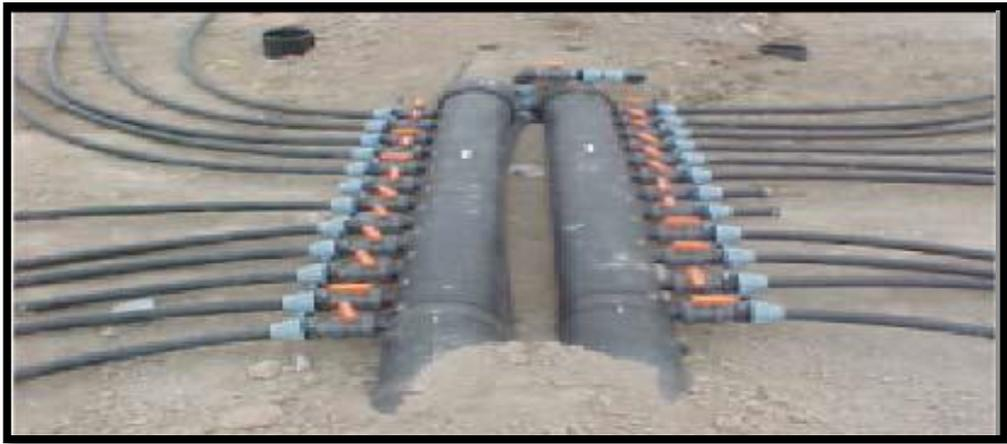
**Figura 1-8:** Sistema de tuberías de conducción conectadas. [17]
