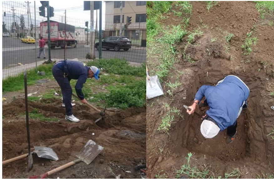
Figura 25. Excavación calicatas Fuente: Esteban Wladimir Tenecota Paredes
