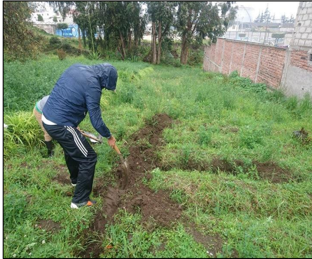
Figura 21. Limpieza capa vegetal Fuente: Esteban Wladimir Tenecota Paredes
