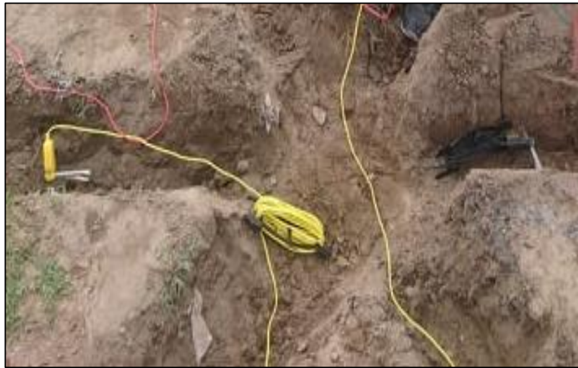
Figura 22. Electrodo en el suelo Fuente: Esteban Wladimir Tenecota Paredes
