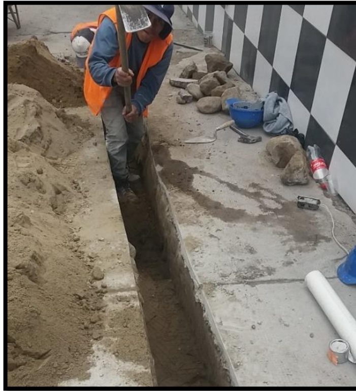
Figura 24 Excavación manual fuente: Carlos Pinto – Edwin Villacis
