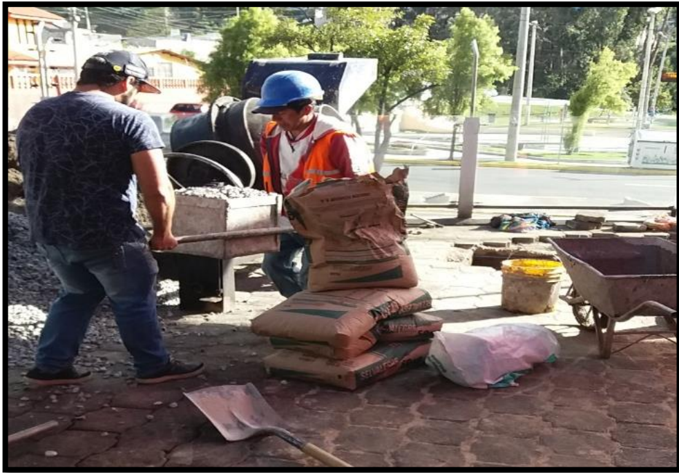
Figura 20 Muros de hormigón fuente: Carlos Pinto – Edwin Villacis
