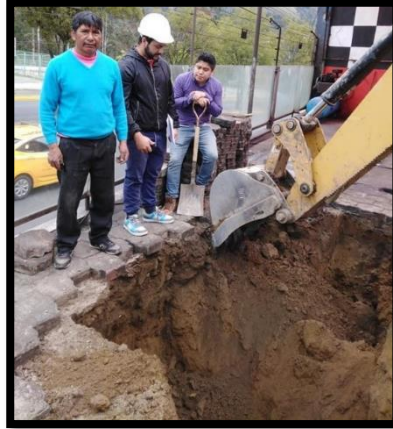
Figura 16 Excavación fuentes: Carlos Pinto – Edwin Villacis
