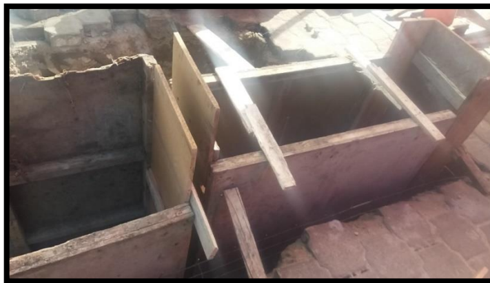
Figura 19 Encofrado fuente: Carlos Pinto – Edwin Villacis
