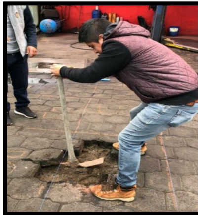
Figura 15 Limpieza y desbroce fuente: Carlos Pinto – Edwin Villacis
