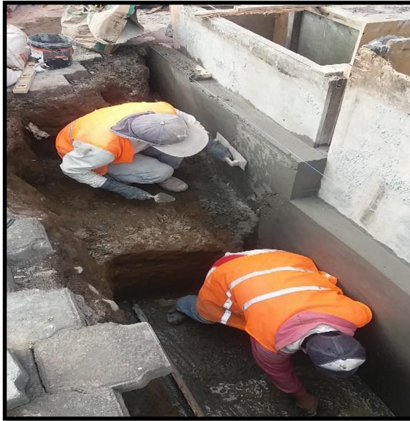
Figura 23 Masillado y alisado fuente: Carlos Pinto – Edwin Villacis
