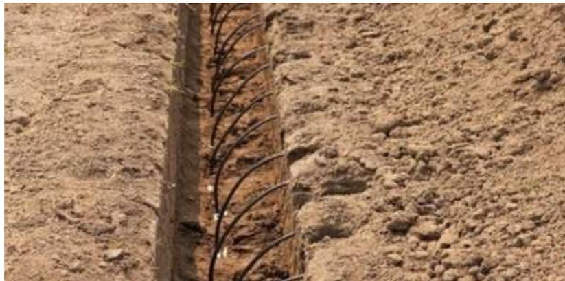
*Ilustración 31: Ilustrativo de riego subterráneo*
