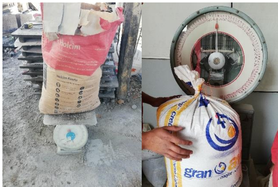
Ilustración 18. Preparación y pesaje del material.
