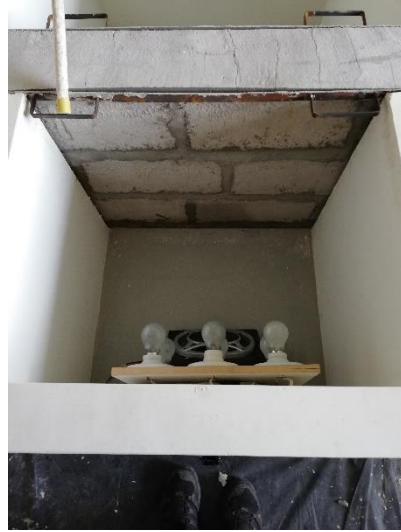
Colocación de pared en la cámara.
