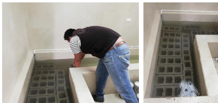
Ilustración 22. Curado de los bloques.
