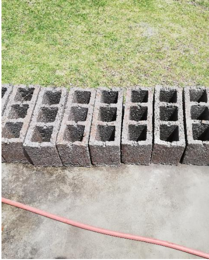
Bloques para elaboración de pared.
