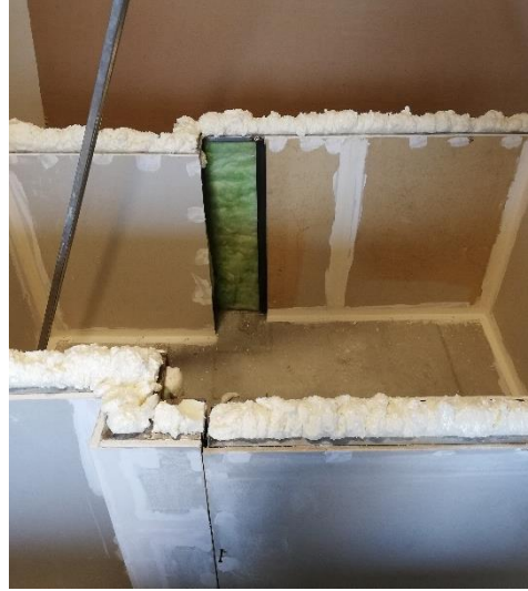
Recubrimiento con espuma aislante.
