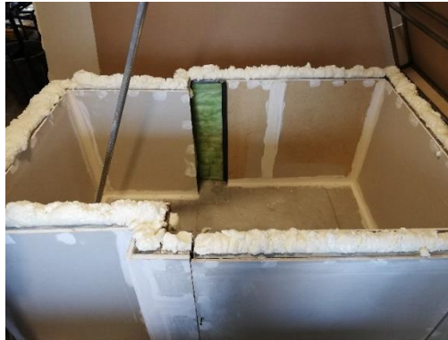
Ilustración 23. Construcción de la cámara hermética.
