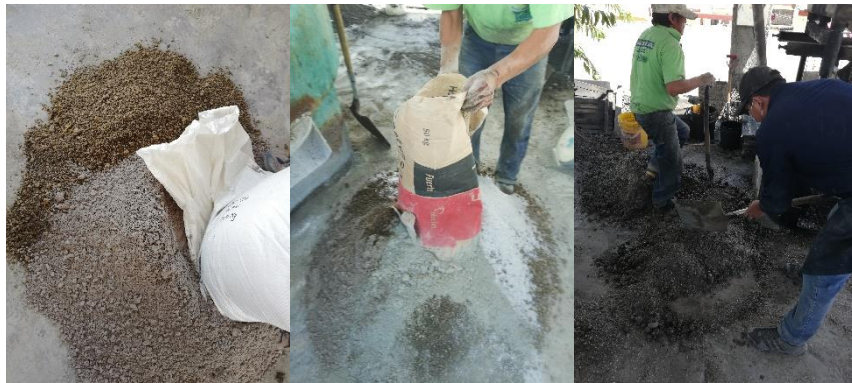
Ilustración 19. Mezcla de los materiales según la dosificación.
