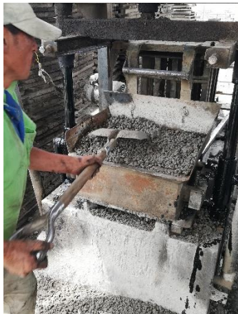
Vibro-compactación de bloques.
