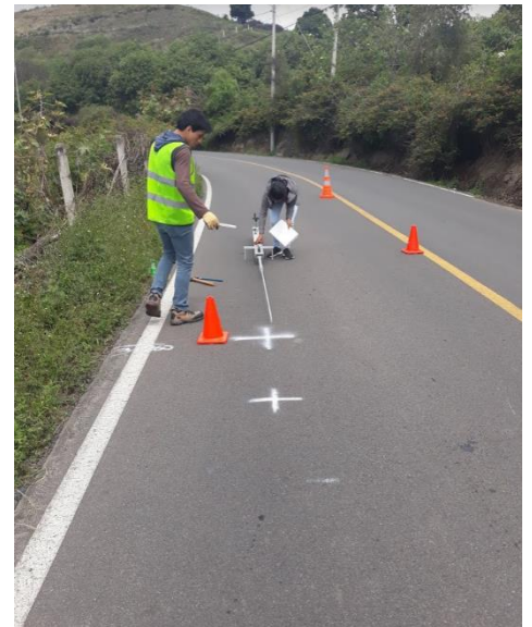
Colocación de la viga benkelman
