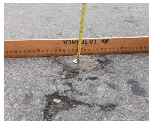
Hueco severidad baja
