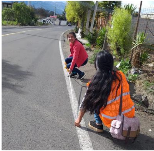
Evaluación de PCI falla Fisura de Borde
