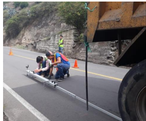
Colocando la Viga Benkelman
