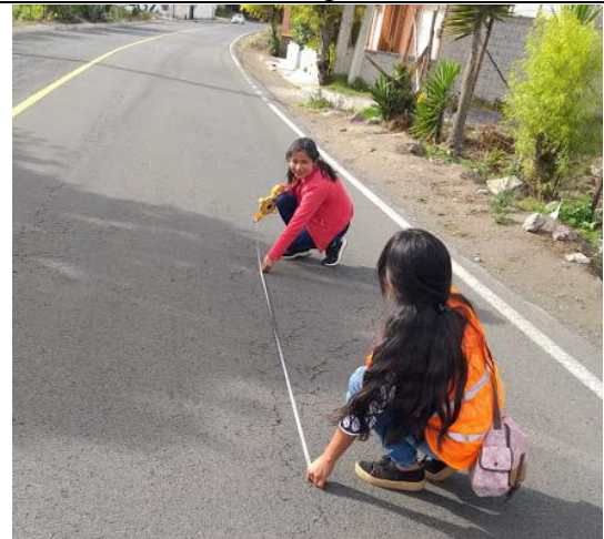
Evaluación de PCI falla Piel de Cocodrilo
