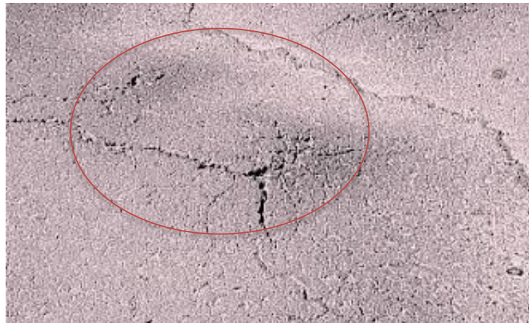
Figura 45. Hinchamiento de nivel de severidad media
