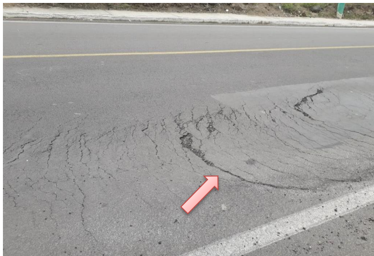
Figura 40. Desplazamiento de nivel de severidad alta
