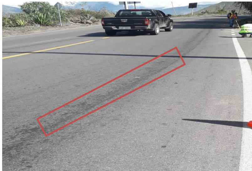
Figura 6. Exudación de nivel de severidad bajo
