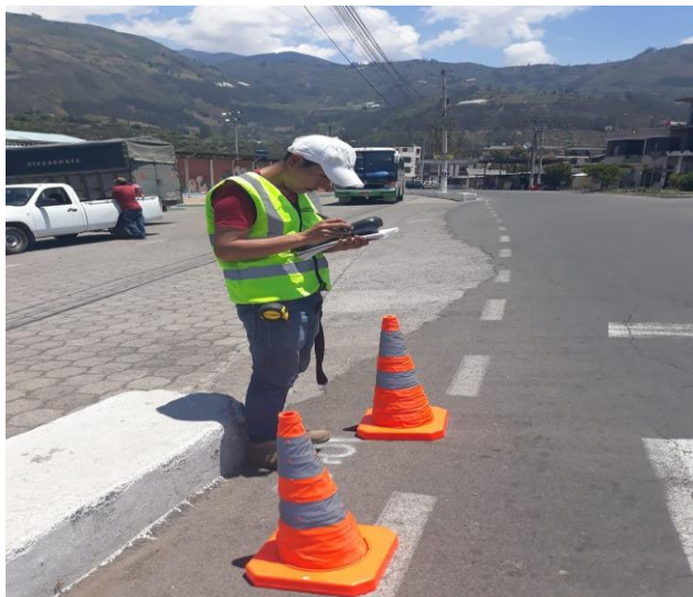
Figura 49. Levantamiento topográfico de la vía con RTK-10
