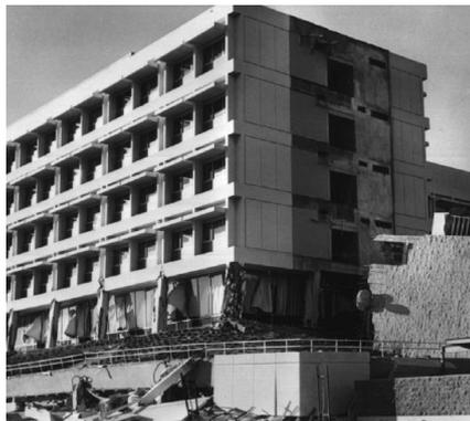
(a) Muros de corte solo en los cuatro pisos superiores
