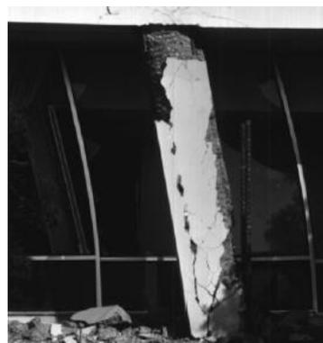
(d) Deformación de una columna reforzada en espiral
