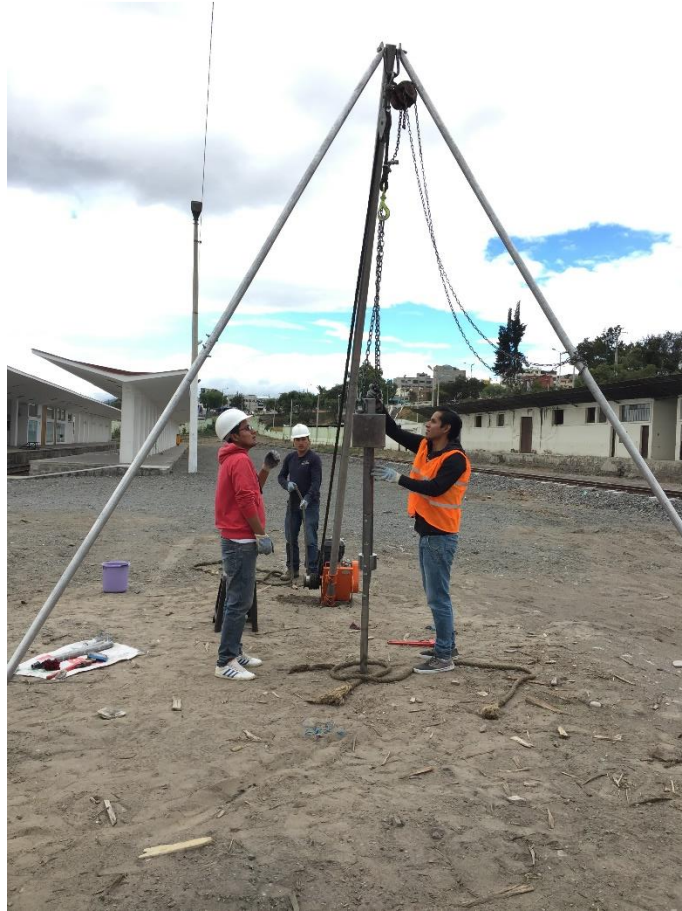
Fotografía 1: Preparación del Equipo SPT
