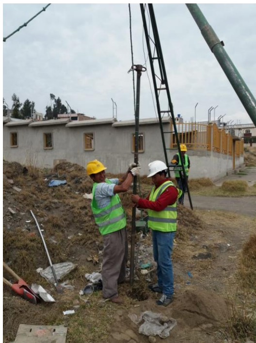
Fotografía 1. Limpieza y colocación del extractor de muestras
