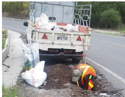
Gráfico 5: Elaboración de una calicata Elaborado por: Tixe Edison
