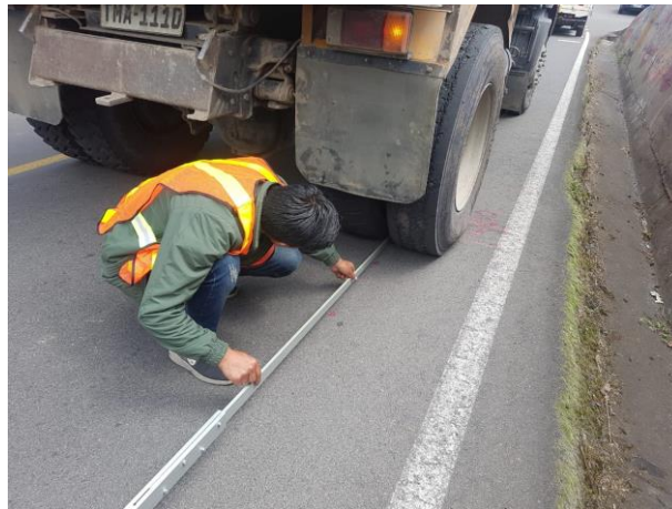
Gráfico 12: Ubicación de la viga Benkelman para el ensayo Fuente: Tixe Edison
