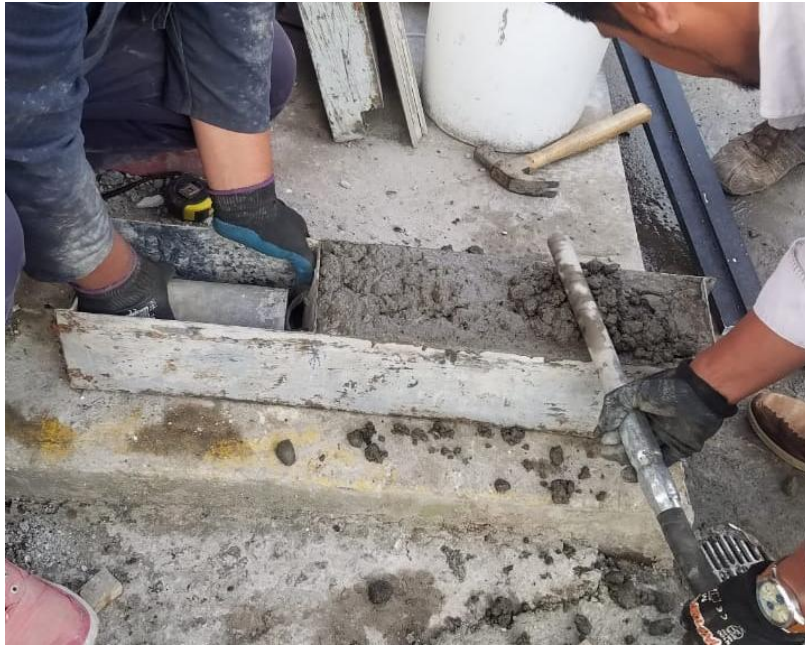
Figura 16. Colado de hormigón. [Autor]
