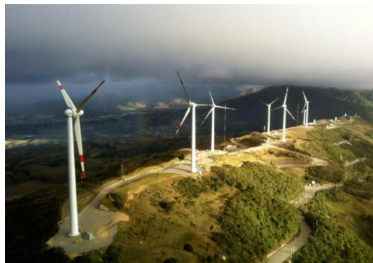
Figura 4. Parque eólico Villonaco [13]
