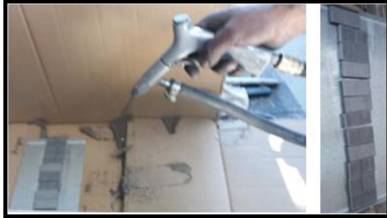
Figura 3-10: Limpieza por chorro mediante sandblasting.
