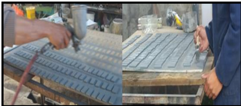
Figura 3-11: Aplicación del recubrimiento mediante pulverización y brochado.
