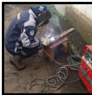
Figura 3-3: Soldadura de las Platinas. Fuente: Autor
