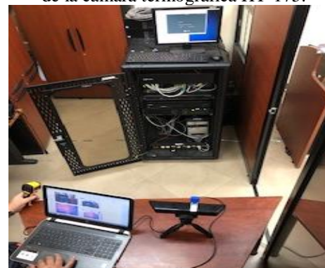
d. Encuadre del sistema de control termográfico 3D.
