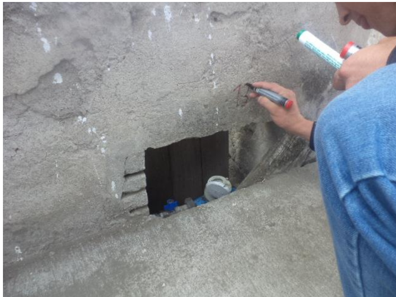
Colocación de las etiquetas en los medidores seleccionados
