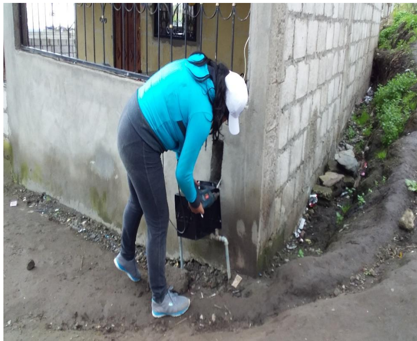
Colocación del dispositivo de medición horaria en el medidor seleccionado.
