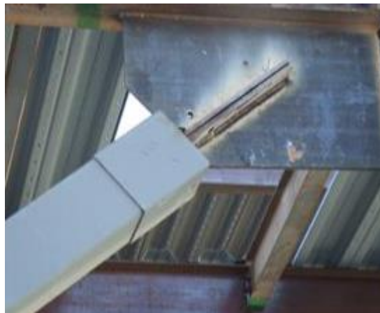
Fig. 25 Conexión soldada
