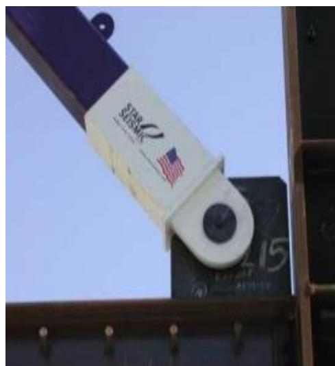
Fig. 24 Conexión rotulada
