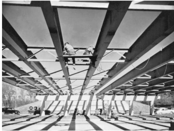
Figura 2.13 Puente Avenida Harrison en Beaumon, TX. (Cortesía de Bethlehem Steel Corporation)
