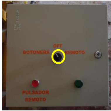
Figura 3.150 Girando el interruptor de tres posiciones hacia la izquierda en el tablero de control
