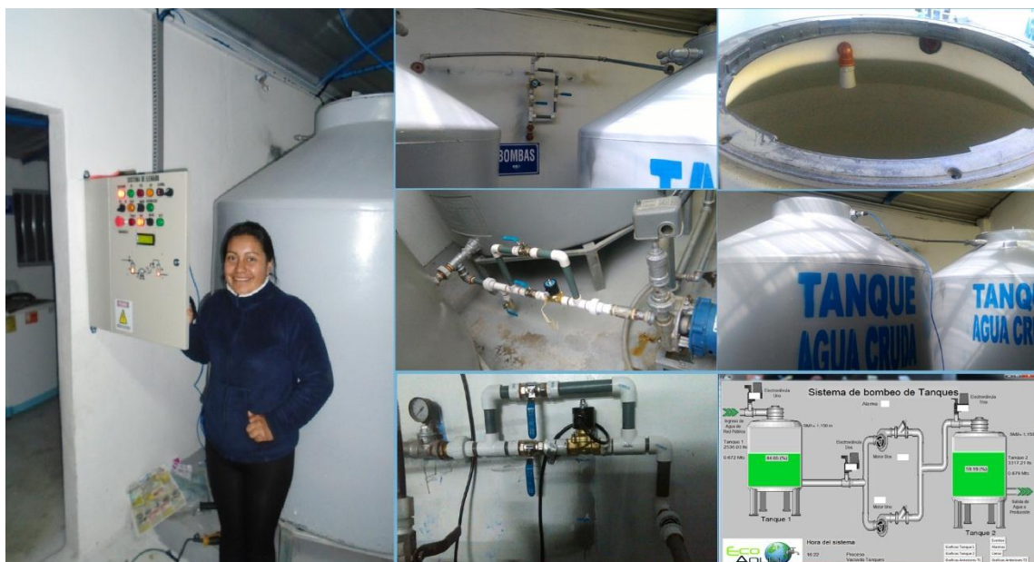
Figura 4. 62: Implementación del sistema de control y alerta para el tanque purificador de agua en la planta purificadora ECOAGUA.
