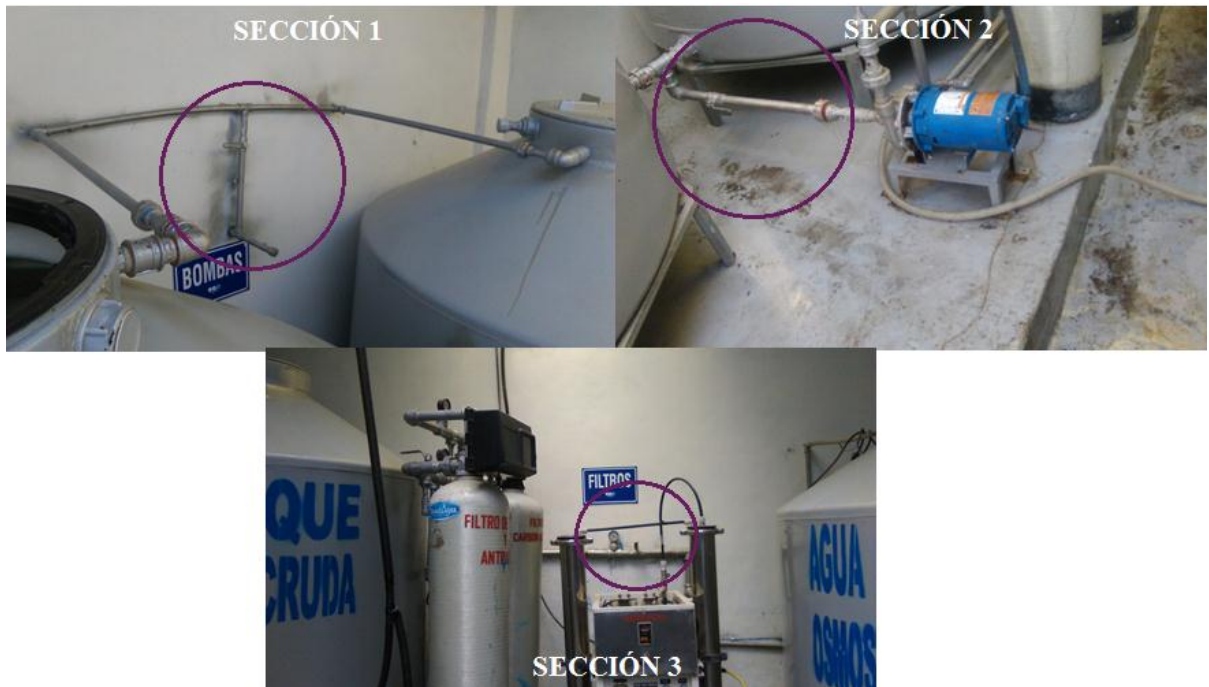
Figura 4. 23: Secciones de tuberías a modificarse en ECOAGUA.
