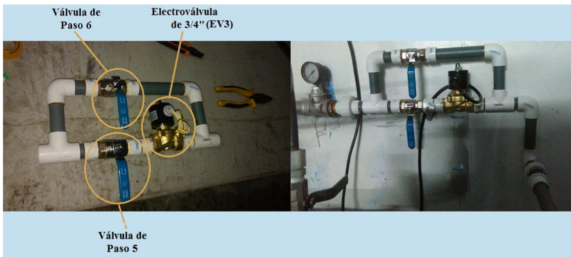
Figura 4. 30: Nueva Tubería sección 3.
