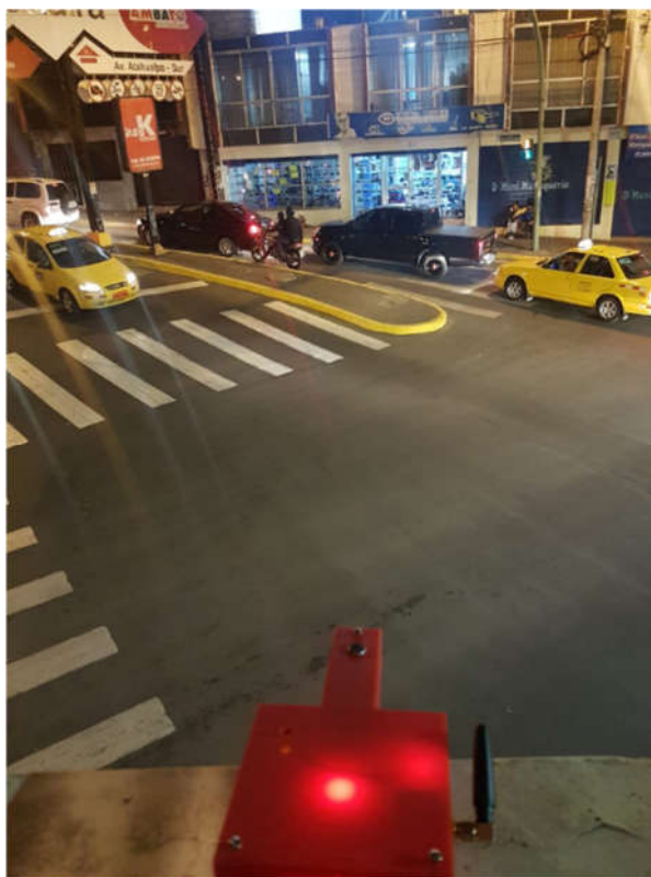
Fig. 4.50 Dispositivo 1 instalado en la Avenida Cevallos y Francisco Flor Fuente: Investigador
