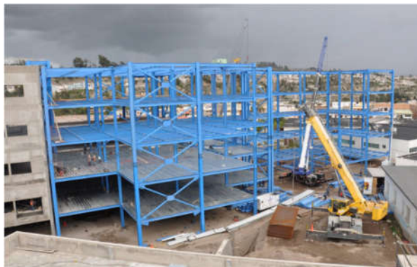
Fig. 4.5 Actividad en Construcción Hospital Docente Ambato [32]
