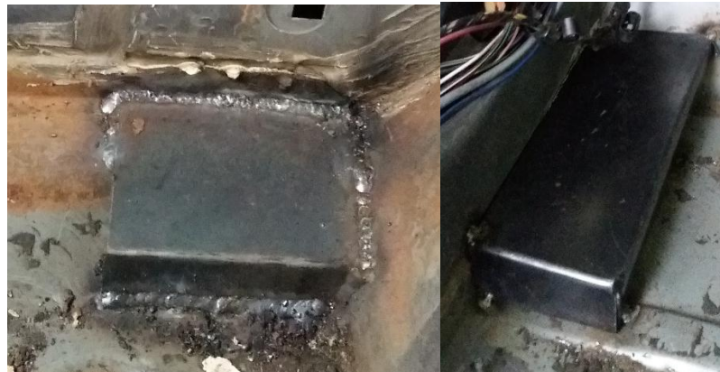
Figura 92 Instalación de placas bases y refuerzos para anclaje
