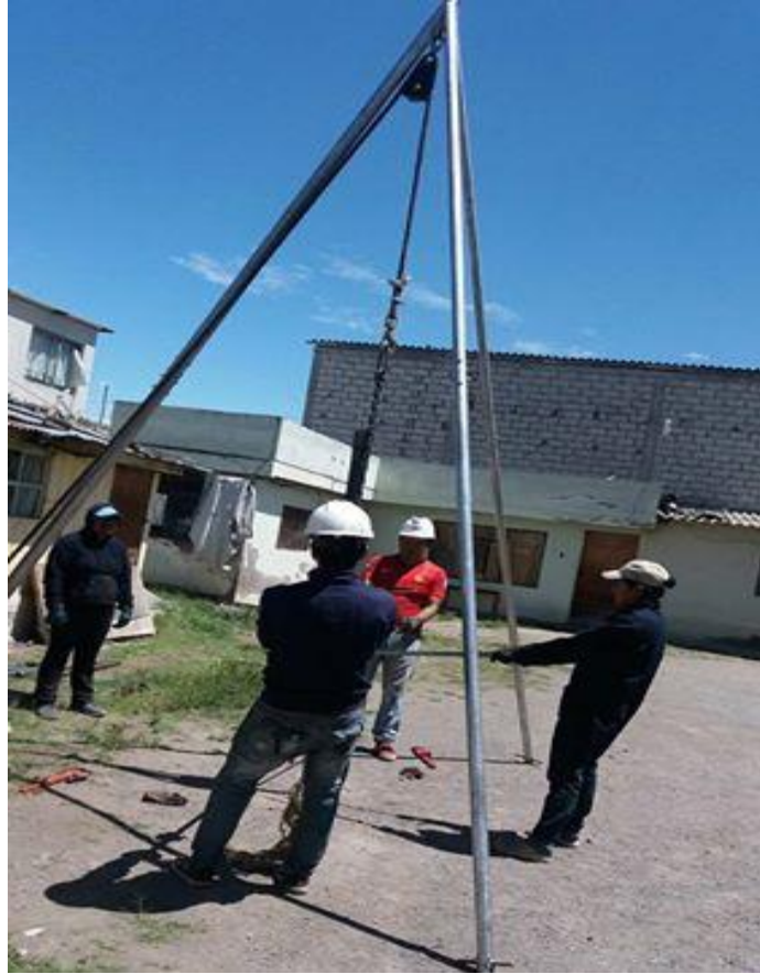
Fotografía 8. Realizando el ensayo SPT y estructura de 1 piso
