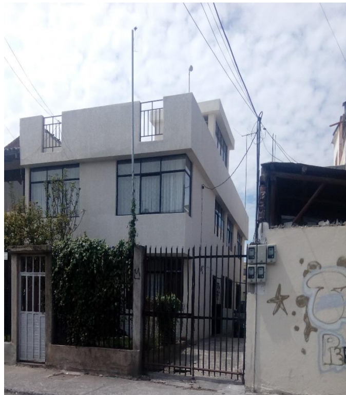
Fotografía 9. Estructura de 2 pisos
