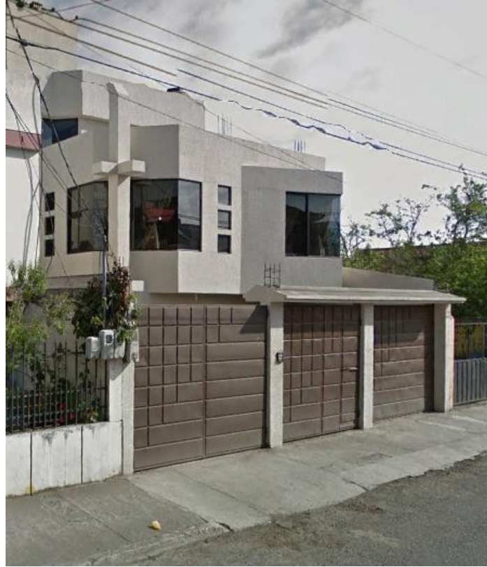
Fotografía 10. Estructura de 3 pisos
