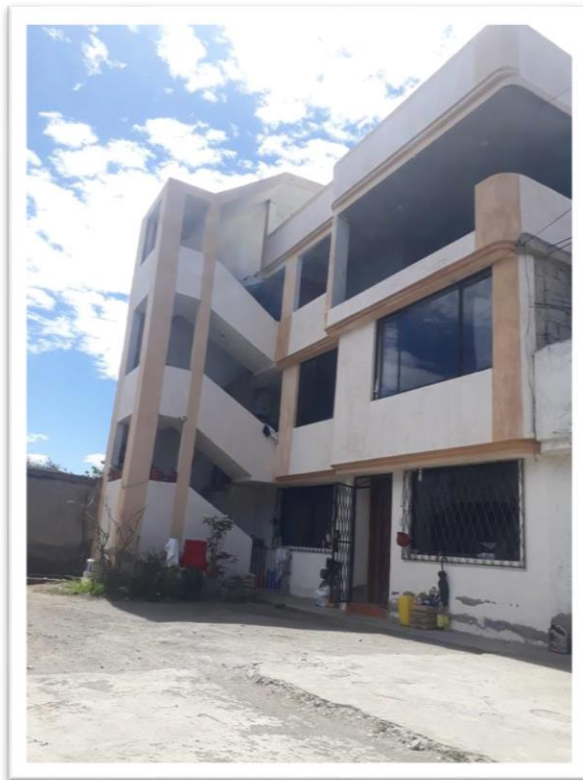
Fotografía# 12 casa de 3 pisos a ser analizada.
