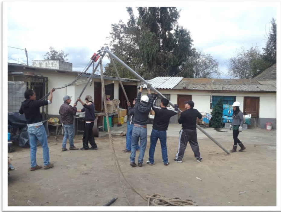
Fotografía# 3 levantamiento del trípode para realizar el ensayo de SPT.
