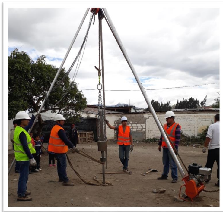
Fotografía# 4 Equipo armado para realizar el ensayo de SPT.
