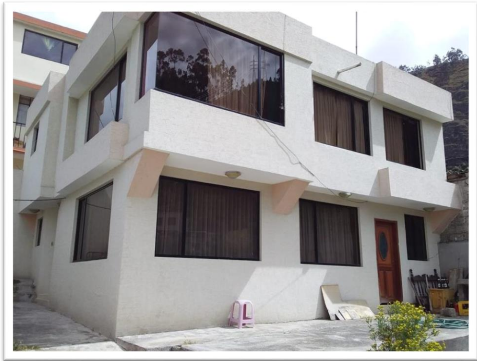
Fotografía# 11 casa de 2 pisos a ser analizada.
