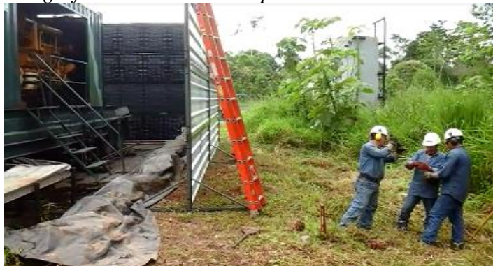
Fotografía 3. Colocación de pantallas de atenuación
