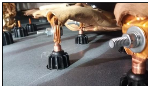
Fig.38 Juego de perno, rodela plana, rodela de presión Galvanizado 3/8 x1" [18].
