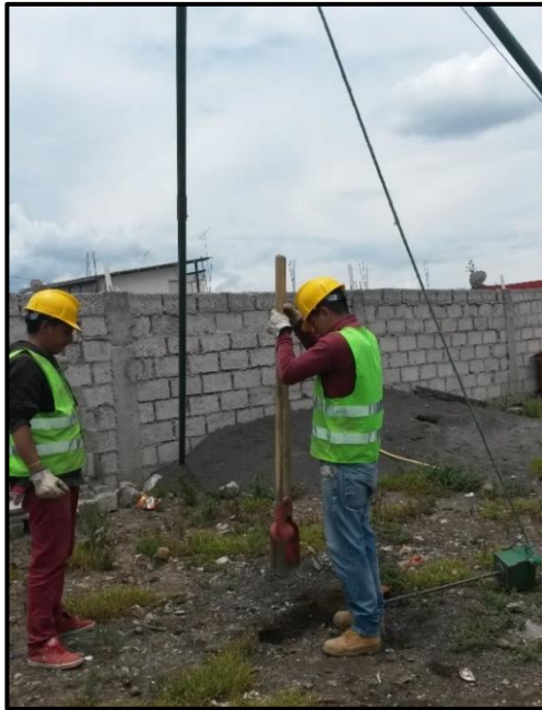
Fotografía 1. Excavación de suelo vegetal
