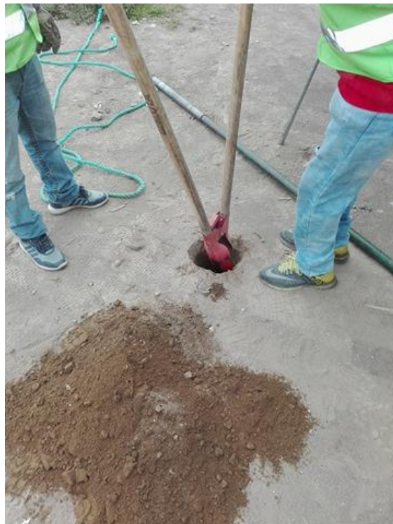
Fotografía 2. Extracción de la capa vegetal
