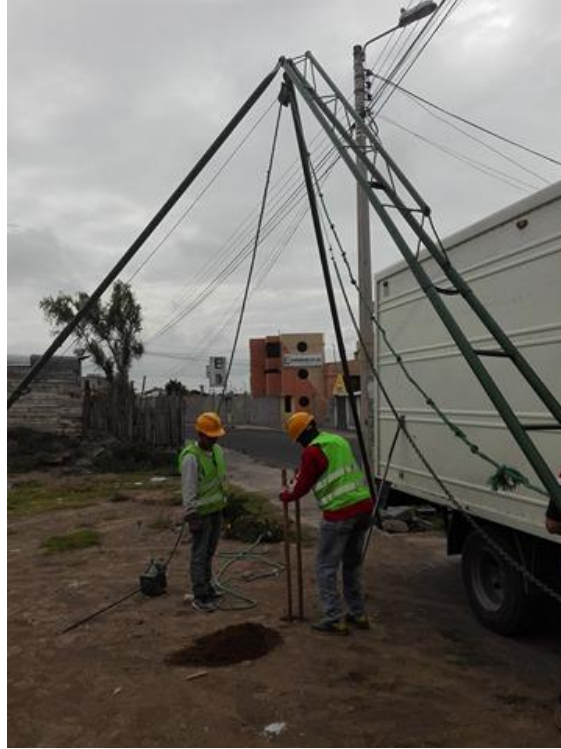
Fotografía 1. Instalación del equipo
