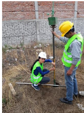
Fotografía 3. Profundidad de la perforación
