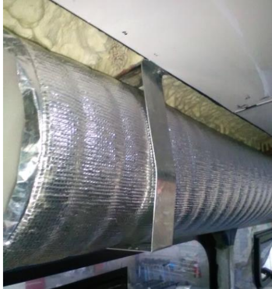
Figura 3-51: Anclaje del Ducto
