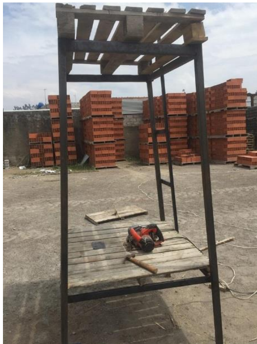
Ilustración 5. Armado de la estructura que soportara el filtro.
