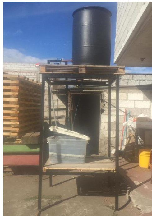
Ilustración 6. Montaje del filtro sobre la estructura.
