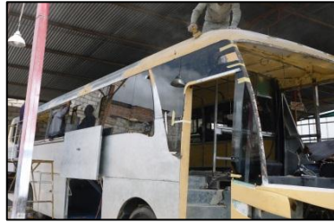
Fig. 26 Instalación de ventanas. Fuente: Carrocerías COPSA.
