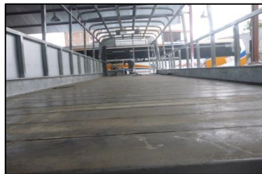
Fig. 15 Armado de piso. Fuente: Carrocerías COPSA.
