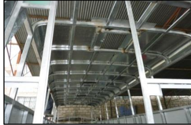
Fig. 20 Forrado exterior del techo. Fuente: Carrocerías COPSA.
