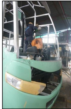
Fig. 18 Armado de estructura frontal. Fuente: Carrocerías COPSA.
