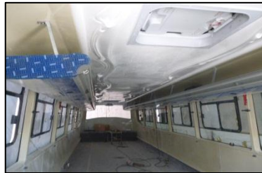
Fig. 27 Forrado interior del techo. Fuente: Carrocerías COPSA.
